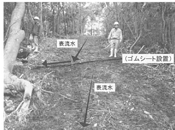
写真-2 浸食防止のゴムシート設置状況
