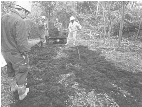
写真-1 バーク敷設状況
