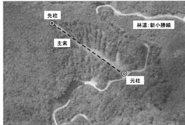
図- 2 魚骨状伐採の状況
