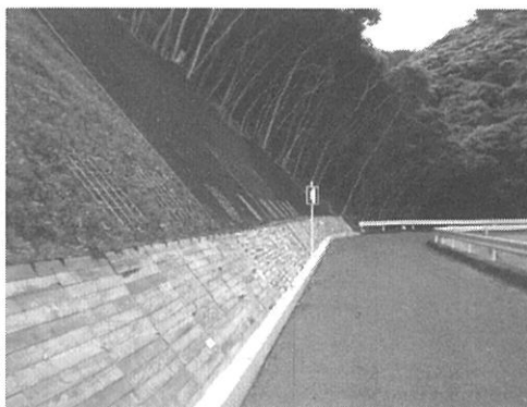
写真1 林道木製法面パネル
