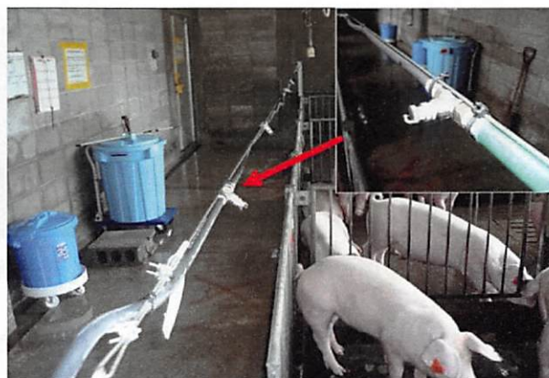
図5 高圧ホースと設置状況
