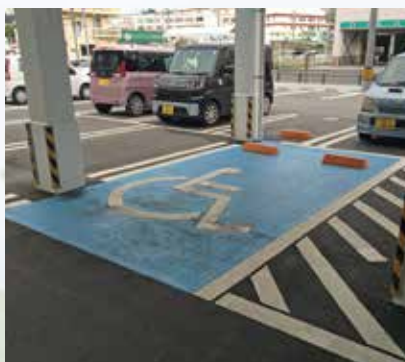
車いす用駐車場設置
