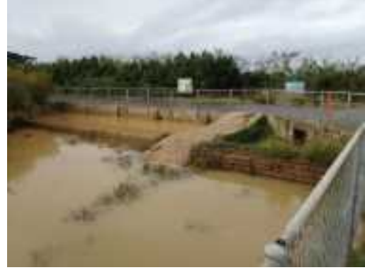
野崎川河口 沈砂池に濁水および土砂が堆積 (H29年度)
