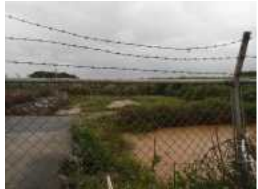
真謝川河口 泥分が堆積・懸濁した沈砂池状況 (H27 年度)
