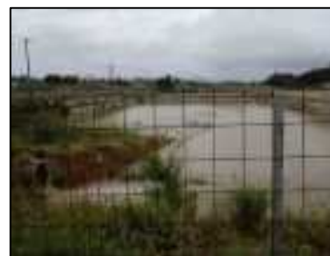
②沈砂池の造成
