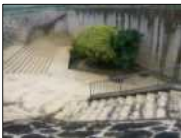
①米須地下ダム
