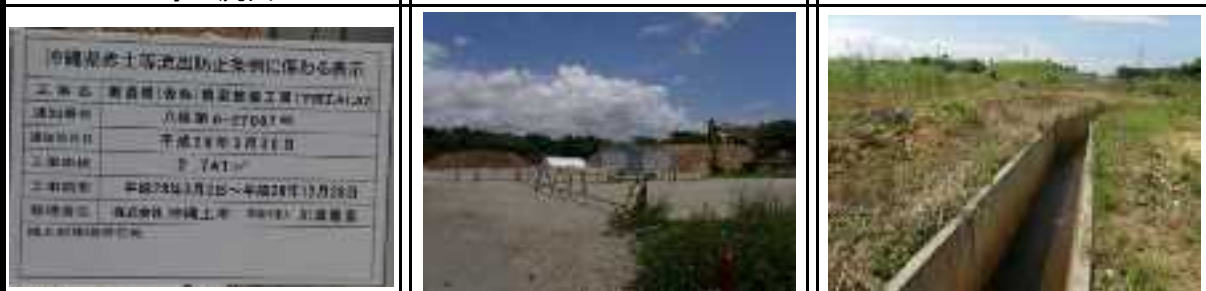
⑨ 赤土等の流出防止防止条例に係わる表示 ⑨ 轟川橋梁工事の状況 ⑩ 石垣による赤土等の流出防止対策
