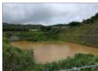
② 整備事業地内沈砂池
