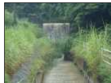
②堰(水質保全対策事業による)
