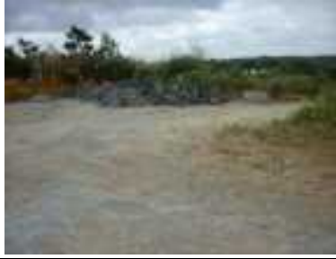
⑭ 工事現場の状況
