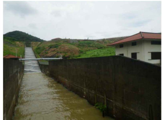
名蔵湾 名蔵ダムからの濁水流出 (平成 25 年度)
