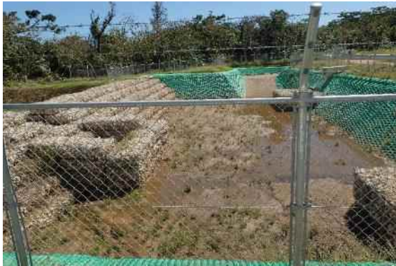
地点⑤ 沈砂池改修完了後
