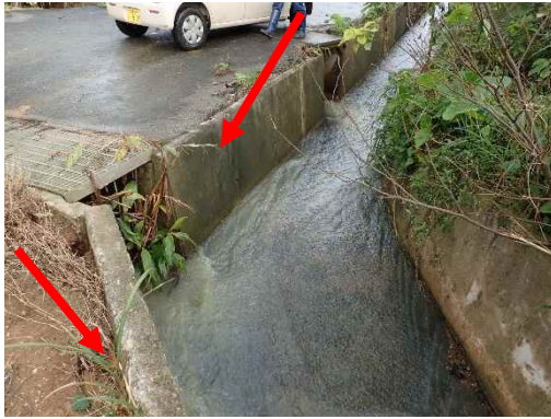
地点⑤ 畑地から河口へ合流する水路(濁り有)
