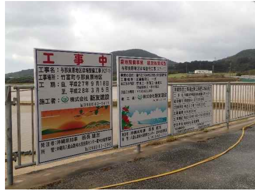
地点③ 工事看板
