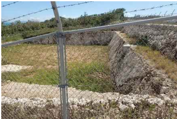
地点⑥ 浸透池
