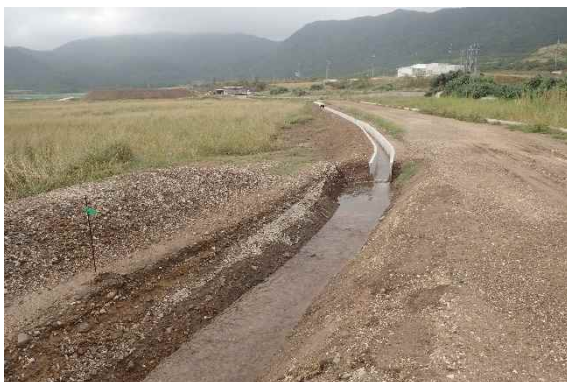
地点② 河口近くの圃場工事状況(流出可能性あり)
