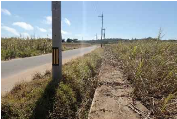
地点⑨ 道路への赤土流出
