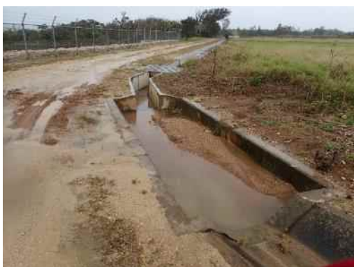
地点⑥ 浸透池直前水路(変化無し)
