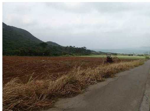
地点⑤ グリーンベルトによる流出防止対策
