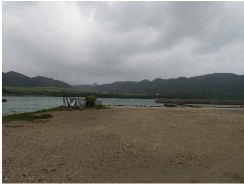
地点⑨ 浚渫工事後の船越港
