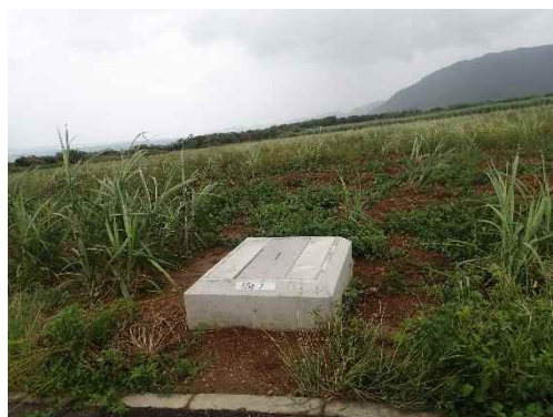
地点⑦ 灌漑施設設備
