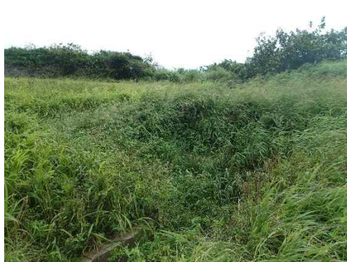
地点⑧ 畑に併設された溜枡の状況
