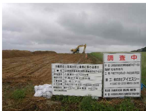
地点⑤ 工事状況
