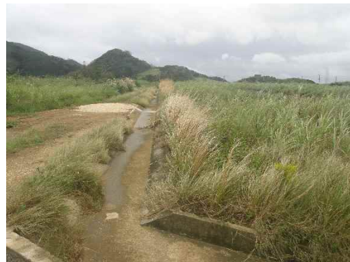
地点⑦ ベチパーによるグリーンベルト(流出無し)
