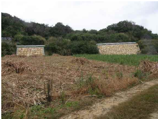
地点⑦ 地すべり復旧工事状況
