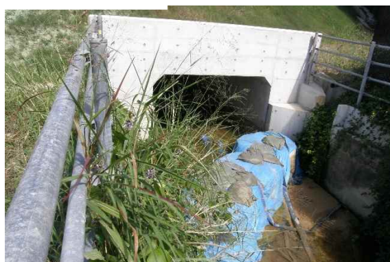
地点④ 周辺水路の状況(濁り無)
