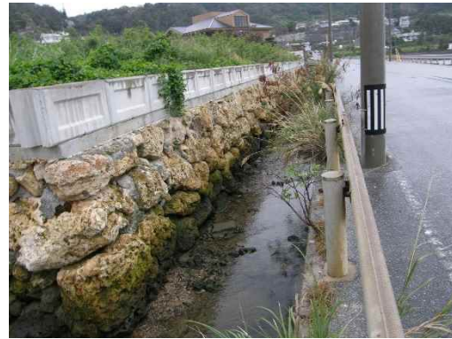
地点② 河口側の水路の状況(濁り無し)
