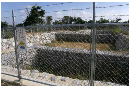
地点⑬ 新設沈砂池
