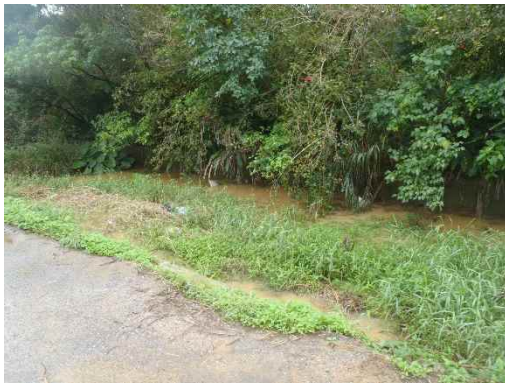
地点② 沈砂池状況
