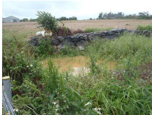
地点① 沈砂池状況
