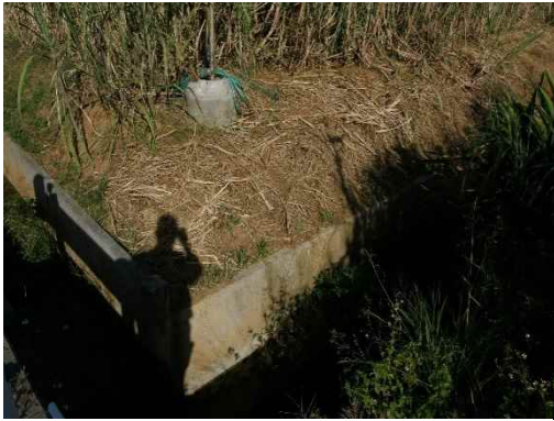
地点⑤ 畑から水路への流出なし
