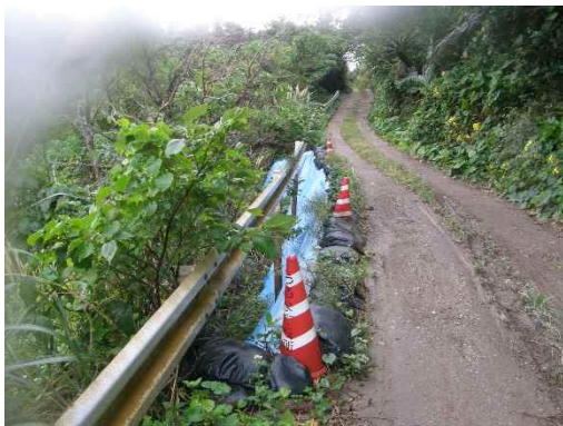
地点⑧ 地すべり発生後の対応状況
