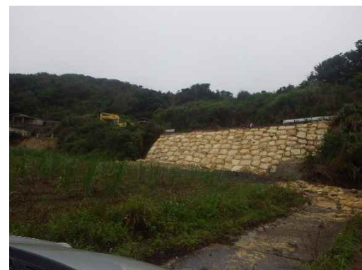
地点⑧ 地すべり復旧工事状況
