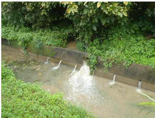
地点⑤ 濁水が水路に流れ込む
