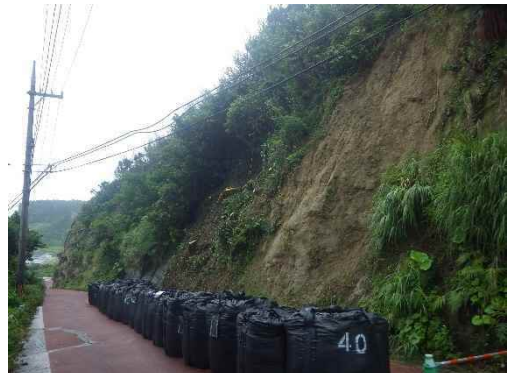
地点⑩ 地すべり発生後の対応状況
