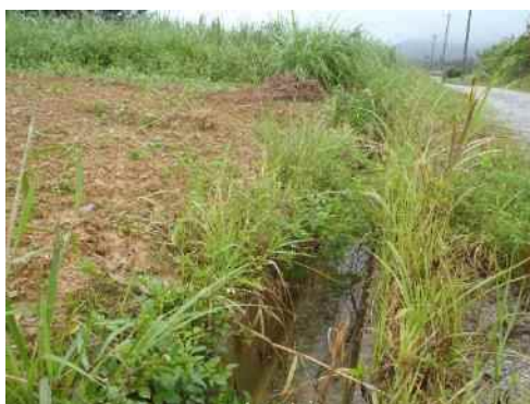
地点⑥ 側溝を流れる水の状況(濁り無し)
