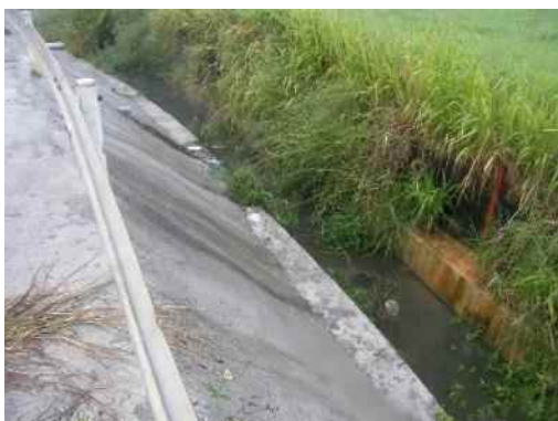
地点⑨ コンクリート舗装された法面
