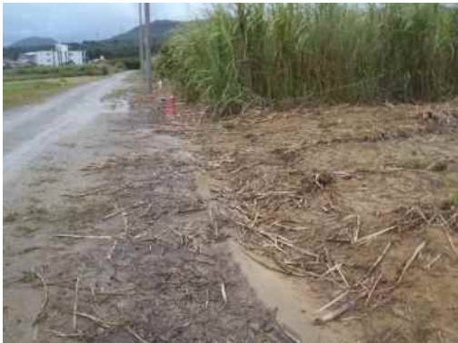
地点⑦ 蓋のある側溝の状況
