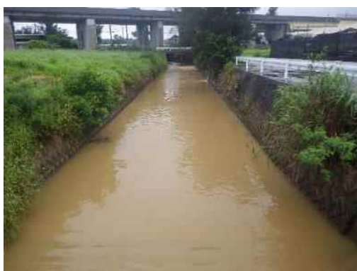
地点⑥ 備前川状況(濁り有り)
