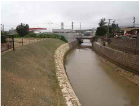
地点⑨ 河川法面工事後状況
