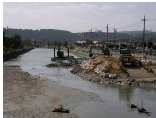
地点⑤ 昨年度工事状況
