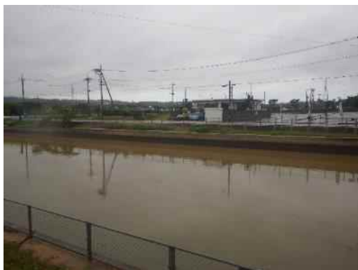
地点⑤ 改修工事終了後状況
