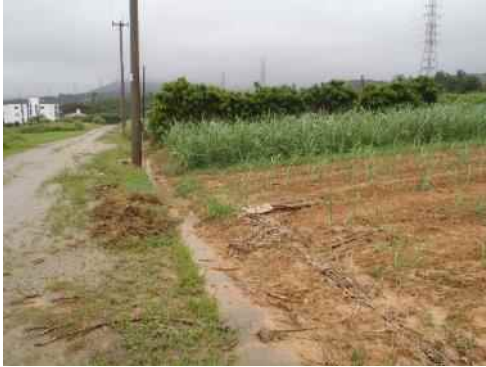
地点⑦ 蓋のある側溝の状況
