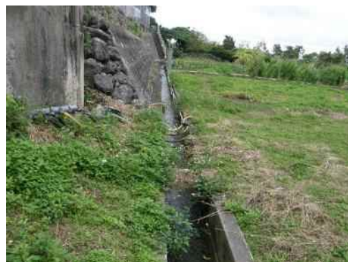
地点⑨ 仲村渠湧水からの水路(濁り無し)
