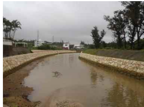
地点⑨ 河川法面工事後状況
