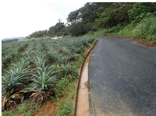
地点⑦ 流出懸念箇所(変化無し)
