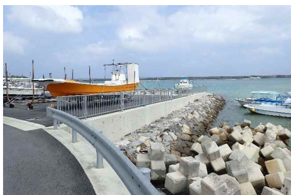
地点② 港揚場工事終了
