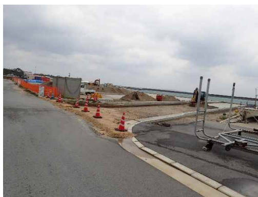
地点② 港内工事状況
