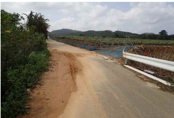
地点⑦ 流出懸念箇所(変化無し)
