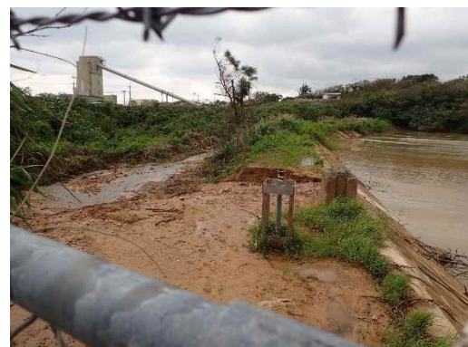
地点⑤ 地点③沈砂池に土砂が流れこむ
