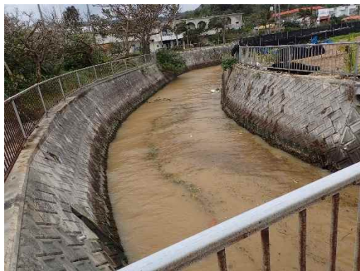
地点① 河口域(濁り有り)
