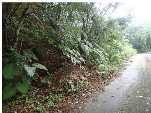
地点⑦ 周辺への流出痕
