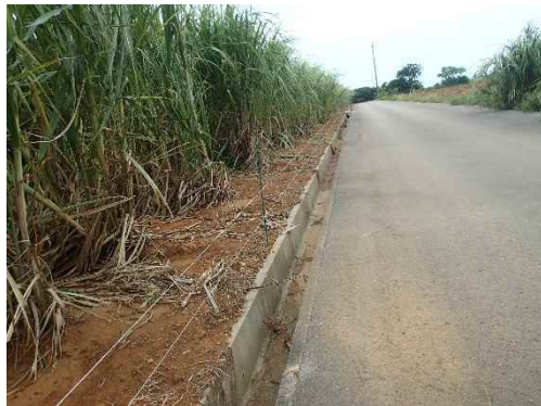
地点⑤ 畑から側溝への流出痕
