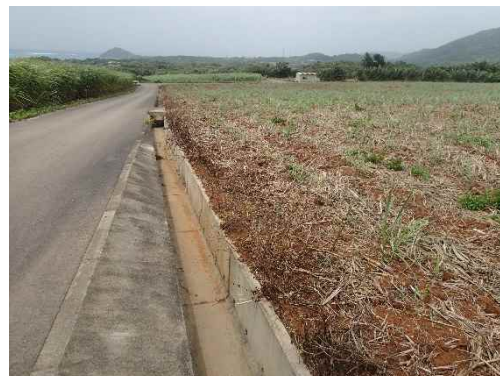
地点⑥ 畑から側溝への流出痕
