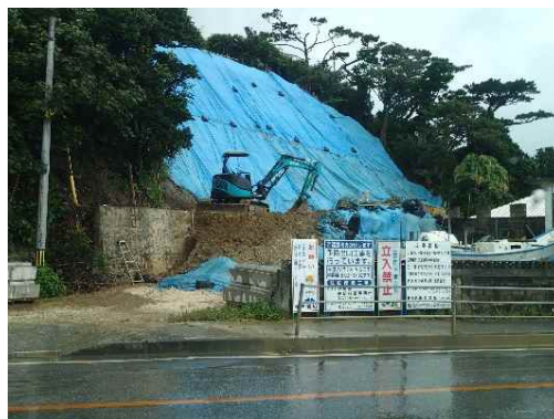
地点⑮ 治山工事状況
