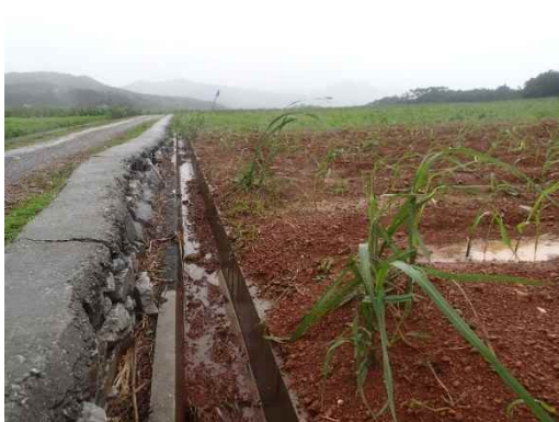
地点⑬ 沈砂池へ流れ込む赤土が堆積した水路
