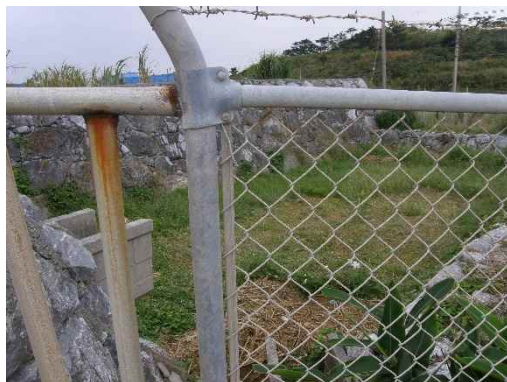
地点⑪ 沈砂池
