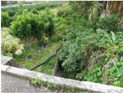
地点⑦ 草本が茂り流出可能性が無くなった
