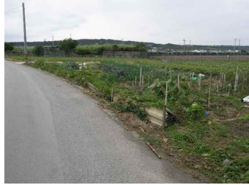
地点⑥ 構造物の隙間から赤土流出(変化無し)
