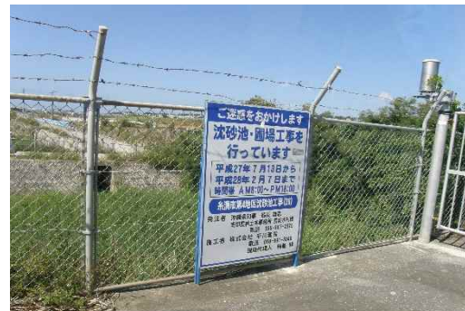
地点⑫ 沈砂池・圃場工事看板
