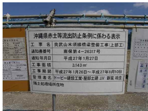
地点⑪ 橋梁工事赤土流出防止に係わる看板
