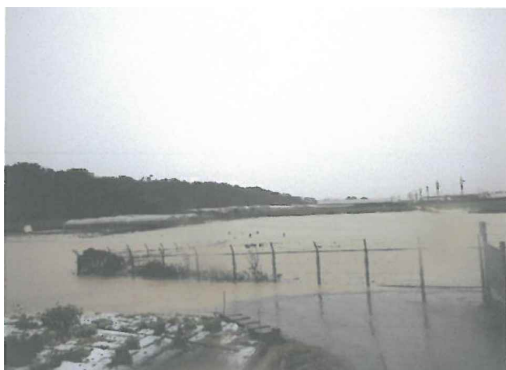
地点㊫ 平成 25 年 5 月浸水状況
