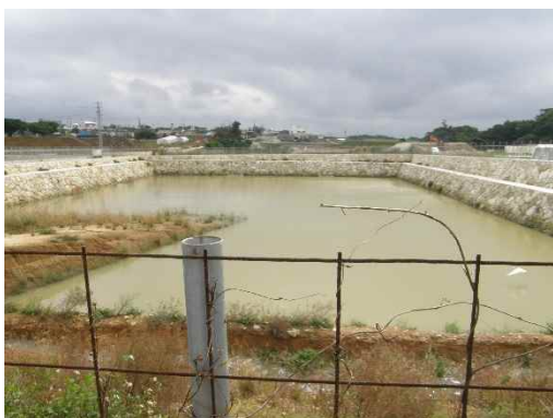
地点⑬ 沈砂池・圍場工事状況
