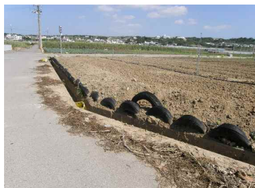
地点④ 対策構造物を越えて赤土流出
