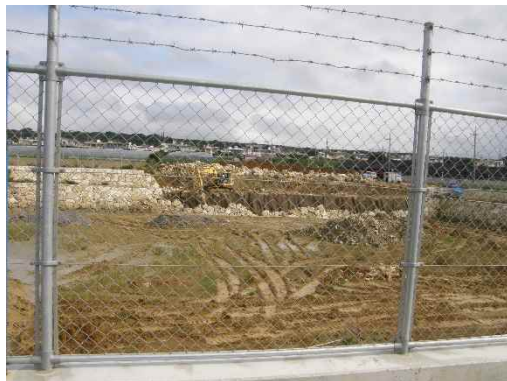
地点⑬ 沈砂池・圍場工事状況
