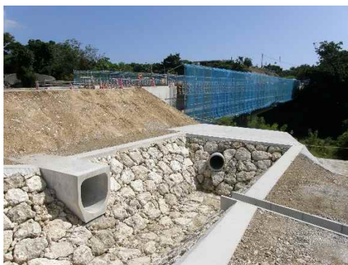
地点⑪ 沈砂池による対策
