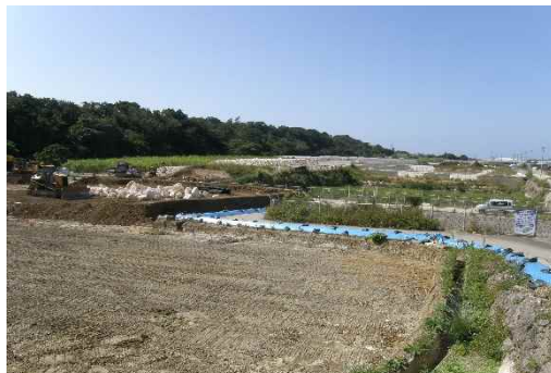
地点⑫ 沈砂池・圃場工事状況
