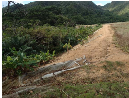
地点 畦畔先の斜面状況
