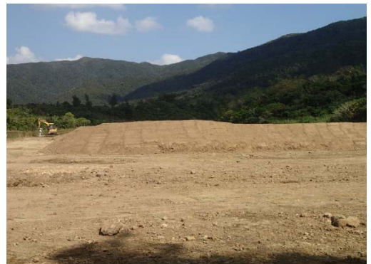
地点 造成工事
