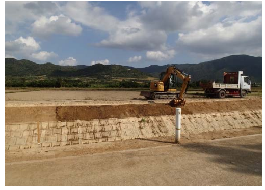
地点 河川整備工事
