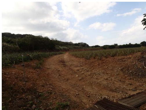
地点 流出源となりうる箇所
