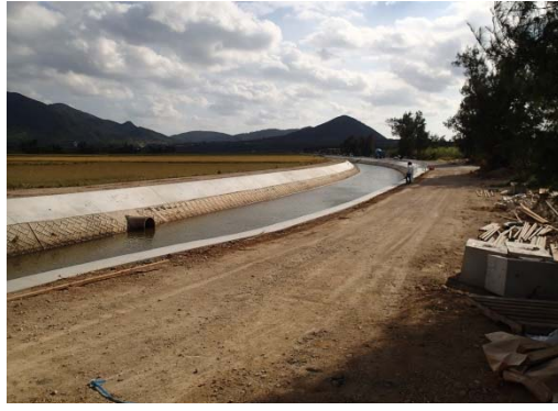
地点 河川整備工事
