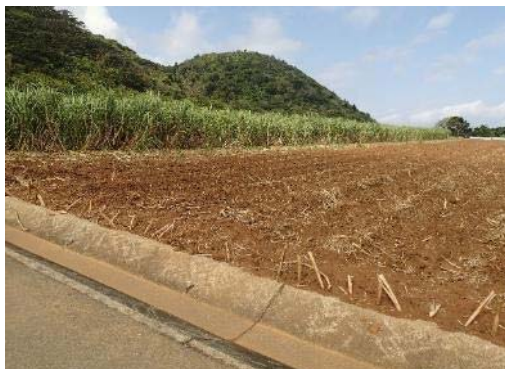
地点 グリーンベルト設置途中(第 1 回目地点 )
