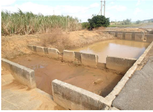
地点 集水桝の状況
