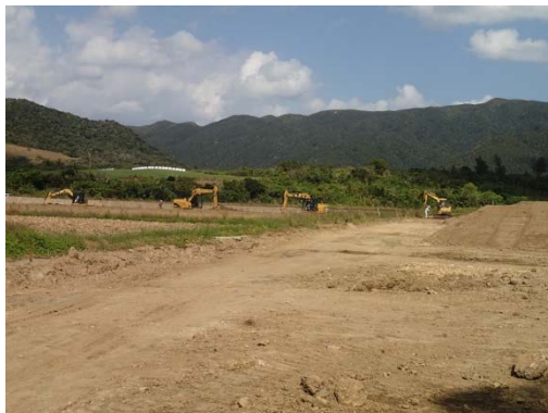
地点 造成工事
