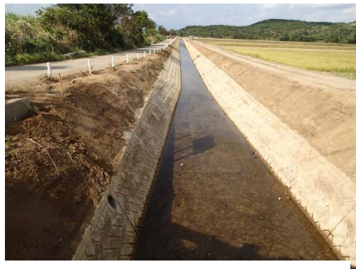
地点 河川内の状況
