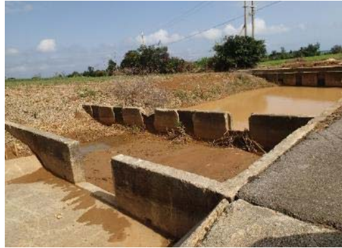
地点 集水桝の状況(第 1 回目地点 )
