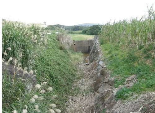
地点 沈砂池から流出無し(1 回目地点 )
