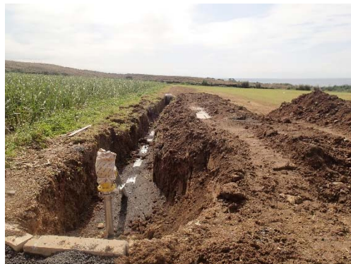
地点 工事の状況
