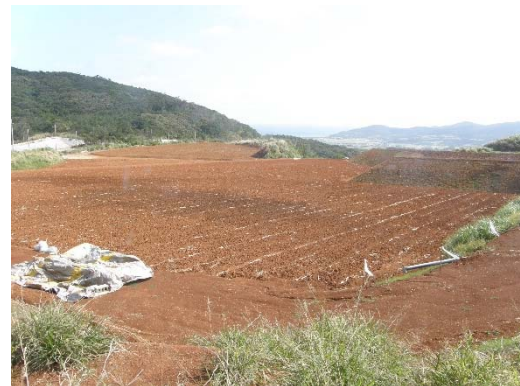
地点 材料山復旧工事状況(1 回目地点 )
