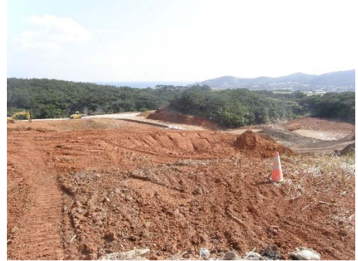
地点 残土仮置き場及び材料山復旧工事状況
