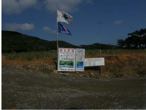
地点 残土仮置き場及び材料山復旧工事看板
