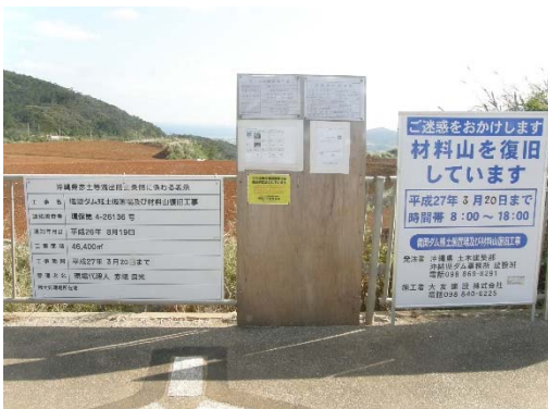
地点 材料山復旧工事看板(1 回目地点 )
