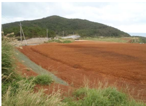
地点 材料山復旧工事
