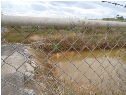
地点 沈砂池の状況
