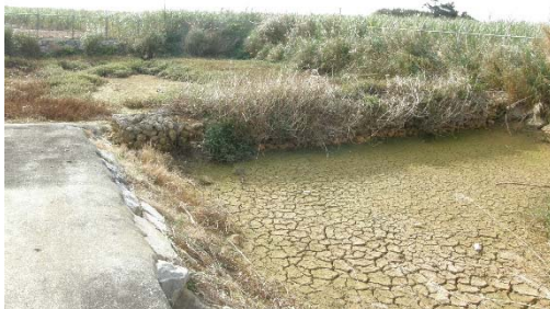
地点 沈砂池の状況(1回目地点 )
