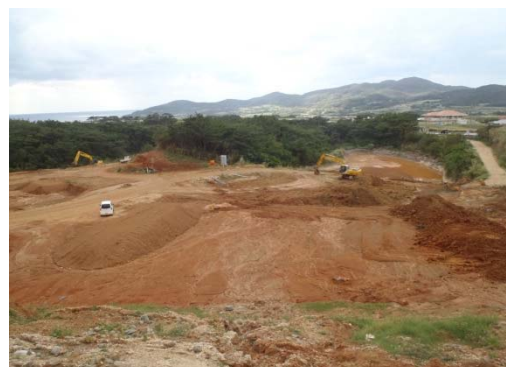
地点 材料山復旧工事
