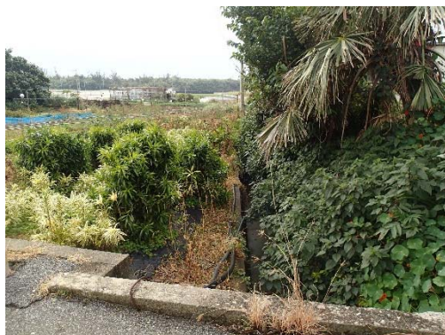
地点 流出可能性が高い箇所(1 回目地点 )
