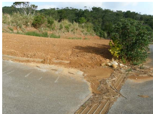
地点 赤土が流出している畑(1 回目地点 )
