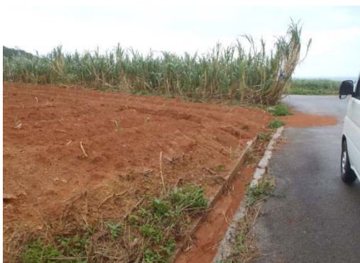
地点 流出痕がある箇所
