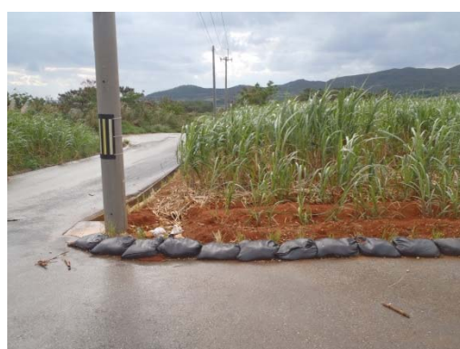
地点 土嚢袋による対策
