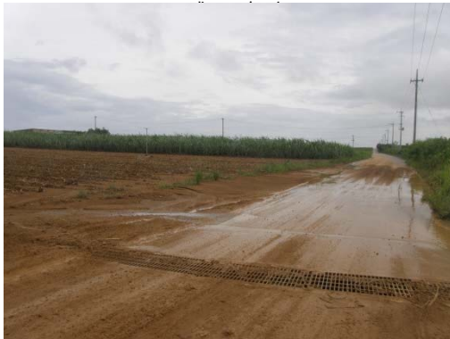
宮良川河口 農地からの赤土等が道路に流出 (平成 25 年度)
