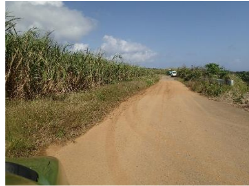
地点 道路への赤土流出(1回目地点 )
