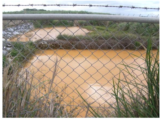
真謝川河口 泥分が堆積・懸濁した沈砂池状況 (平成 25 年度)
