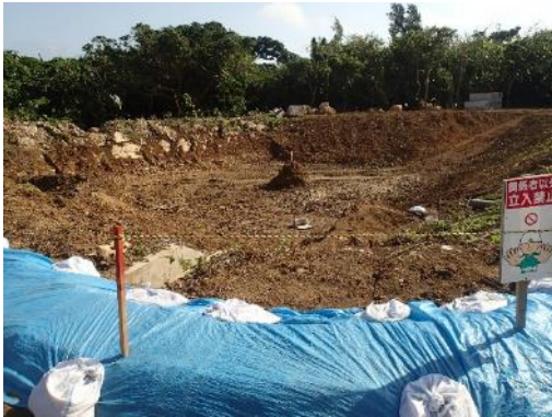
地点 沈砂池改修工事状況
