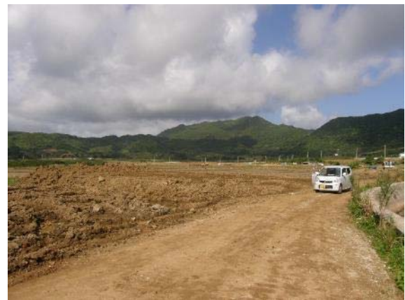
地点 河口近くの圃場工事状況
