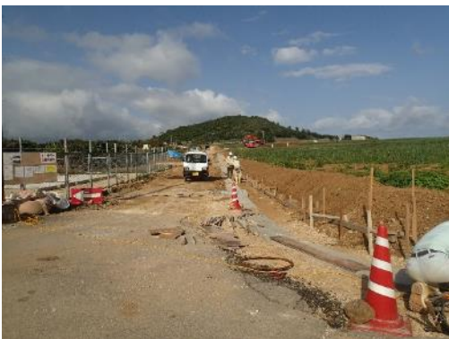
地点 赤土流出防止対策工事の状況
