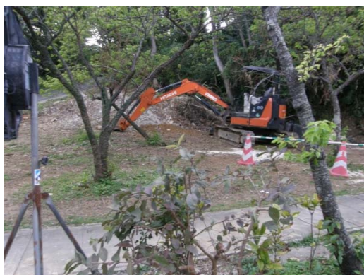
地点 新規確認造成地
