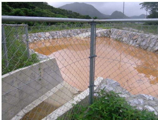
地点 沈砂池状況
