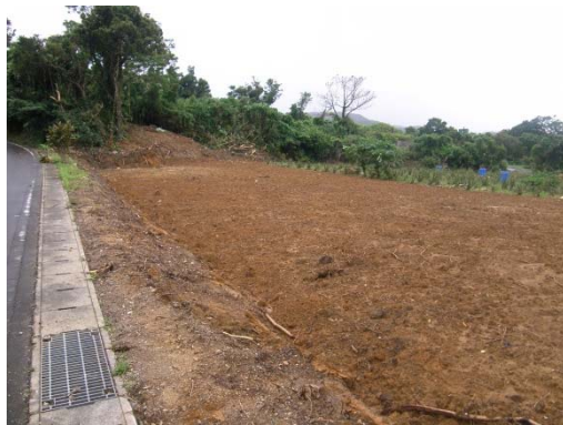
地点 新規確認造成地
