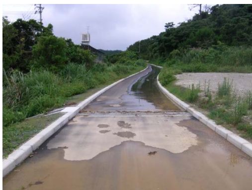
地点 工事終了
