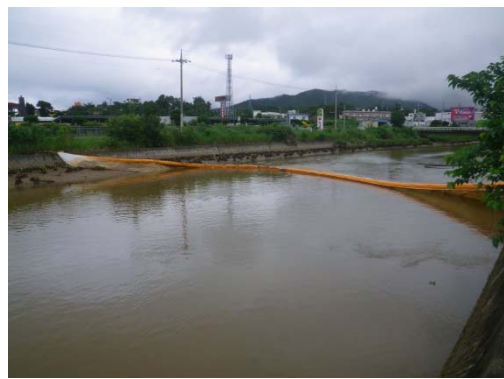
地点 汚濁防止膜の設置
