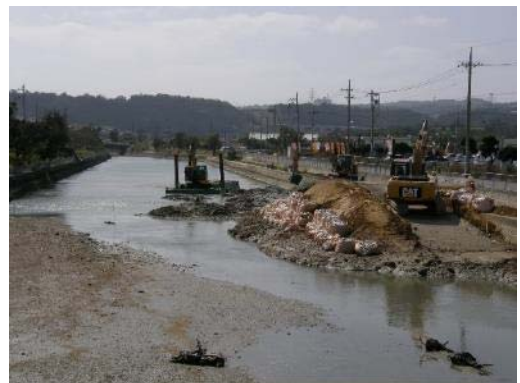
地点 工事状況(第1回目地点 )
