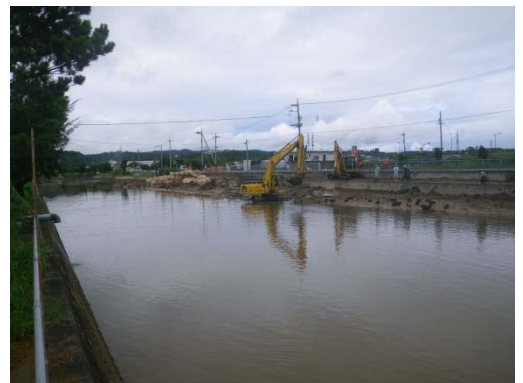
地点 工事状況
