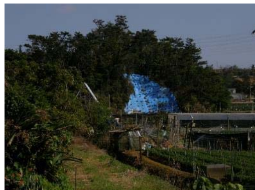
地点 土砂崩れと赤土流出防止対策
