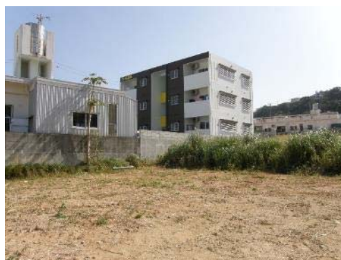
地点 第1回目に流出源と考えられた造成裸地(第1回目地点 )
