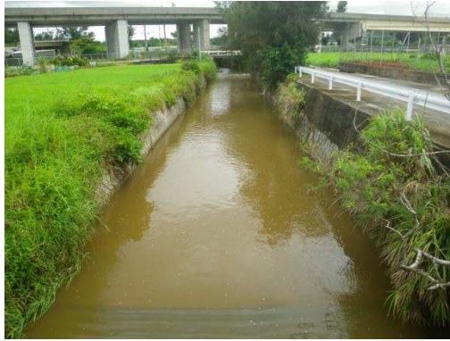
地点 備前川状況(濁り有り)
