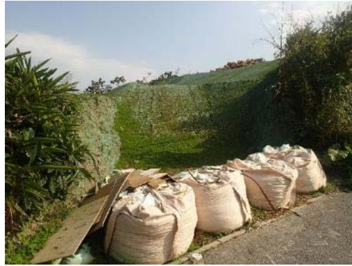
地点 造成地の法面緑化
