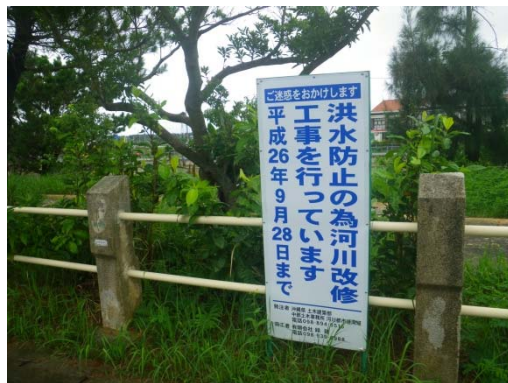
地点 工事看板
