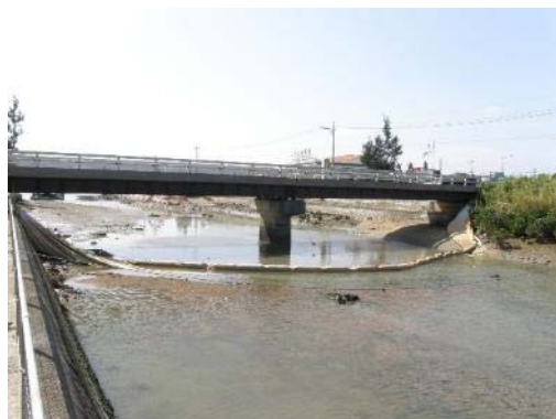
地点 汚濁防止膜の設置(第1回目地点 )
