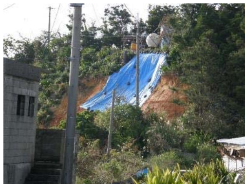
地点 土砂崩れと赤土流出防止対策
