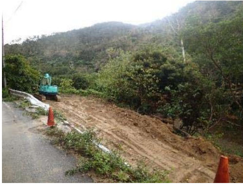
地点 土砂崩れに伴う工事の状況
