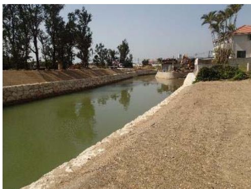
地点 河川法面工事状況
