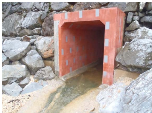
地点 北側カルバート部(濁り無し)
