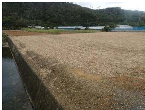
地点 流出無し畦畔対策箇所(1回目地点 )
