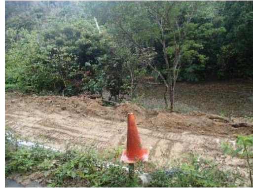
地点 河川と工事状況
