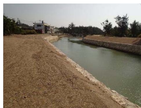
地点 河川法面工事状況
