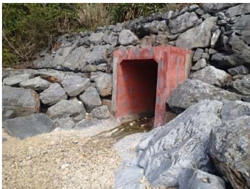
地点 北側カルバート部(濁り無し)
