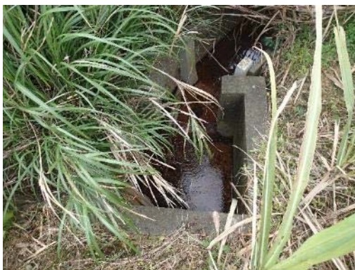
地点 水路に濁水が流れ込む(1 回目地点 )
