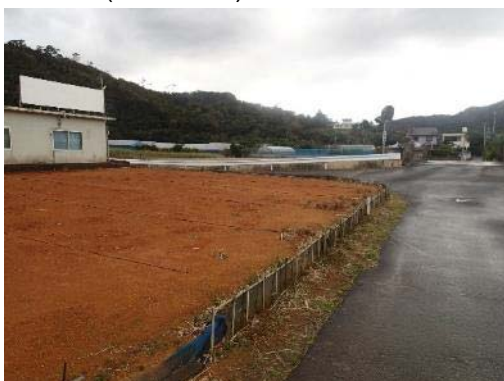
地点 流出無し(足場板対策箇所)(1回目地点 )
