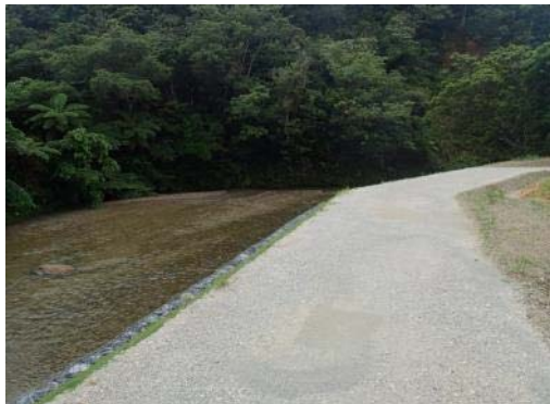
地点 護岸工事終了
