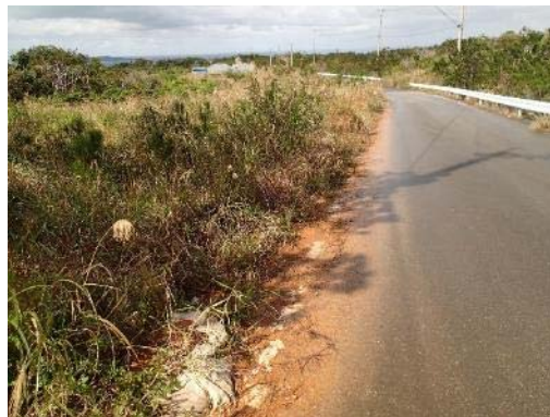
地点 道路への流出(変化無し)(1 回目地点 )
