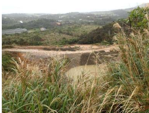
地点 工事状況
