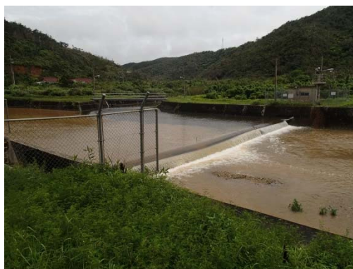
地点 ラバー堰越流状況
