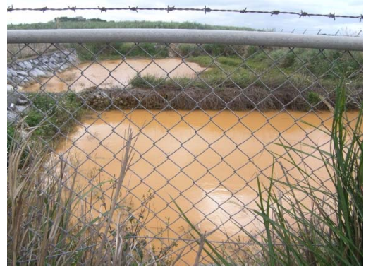
真謝川河口 泥分が堆積・懸濁した沈砂池状況 (平成 25 年度)
