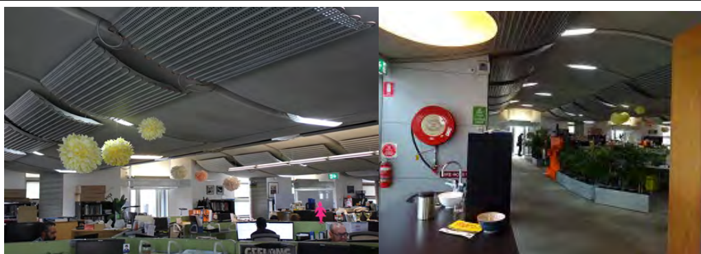
室内の熱を吸収する波形の天井
