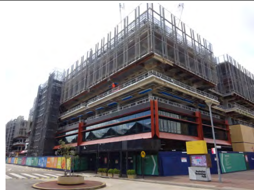
現在建設中の建物
