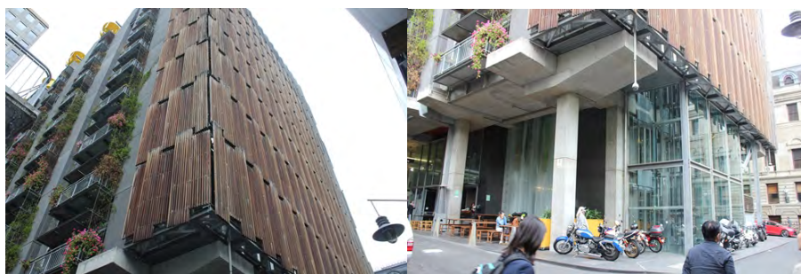
時間と太陽の角度に応じて開閉し、室温を調整する木製スリット
