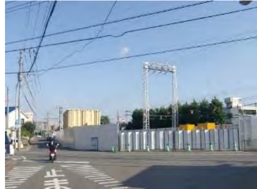
移設前の送電線の様子 (線路上空に設置)
