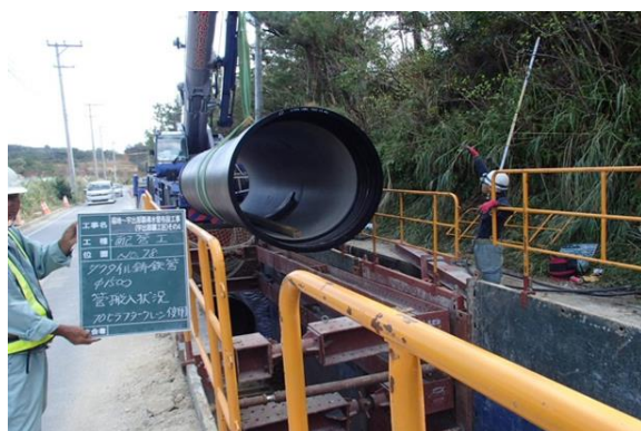
管路更新工事の様子
