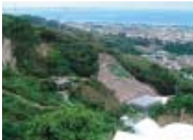
地域防災対策総合 治山事業(中城村)
