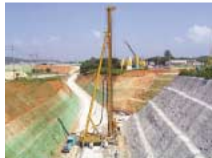
県営かんがい排水事業与勝地区 (地下ダム建設状況)
