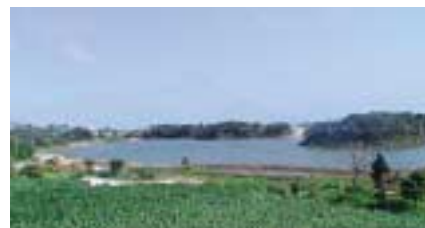
県営かんがい排水事業カンジン地区 (貯水状況)
