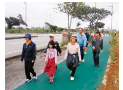
高野西里線(JTAドーム宮古島付近)
