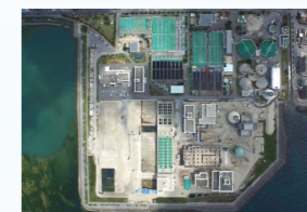
宜野湾浄化センター
