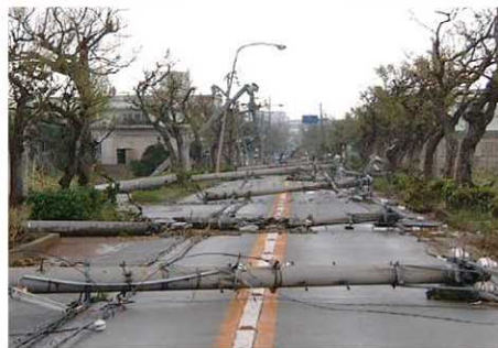
平成15年台風14号による被災
