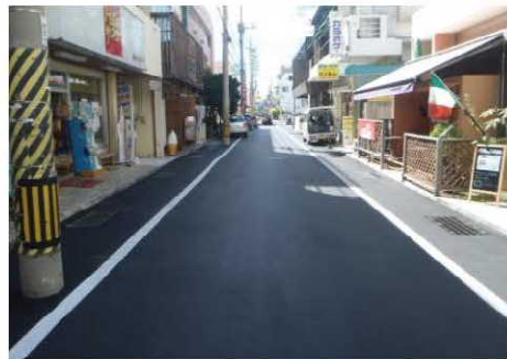
補修後(西里通り)
