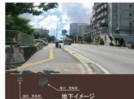
無電柱化実施後
