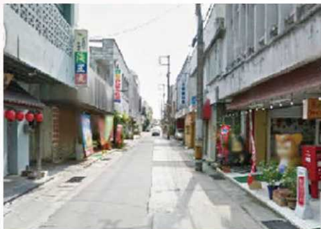
補修前(西里通り)
