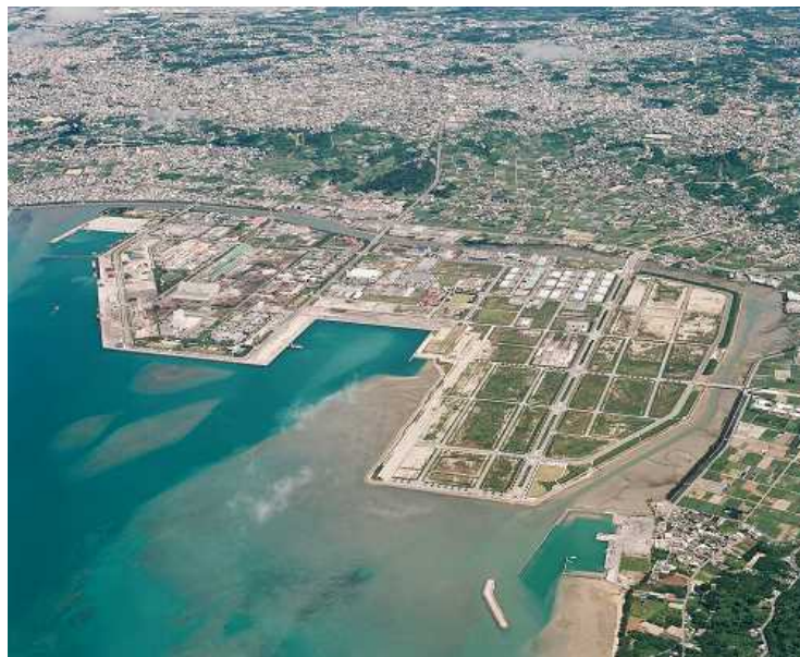
中城湾港（新港地区） 航空写真（平成20年7月）
