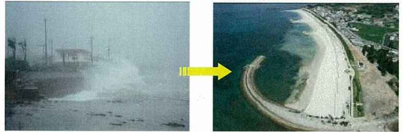
整備前(越波状況)
