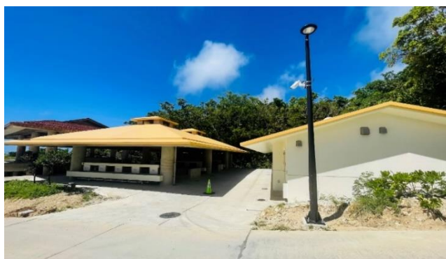
トイレ・シャワー棟、炊飯棟-外観
