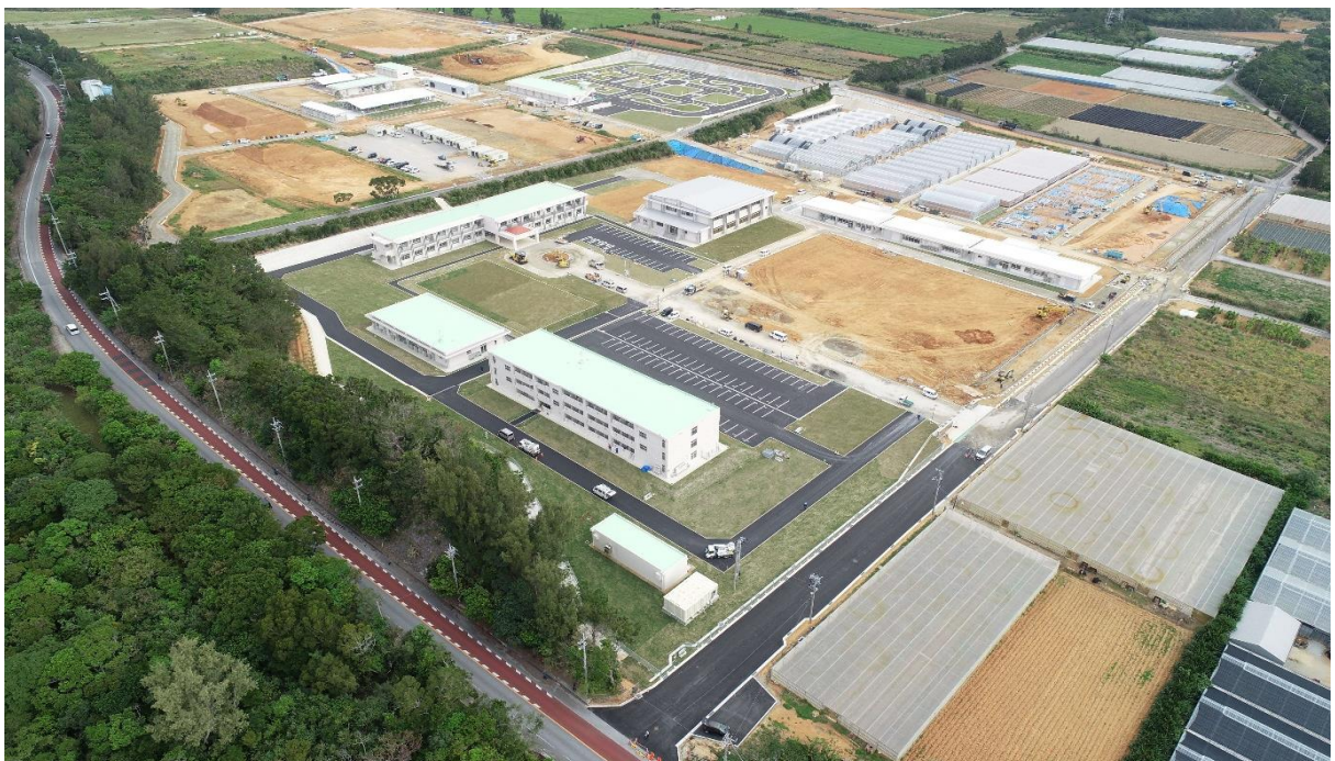
沖縄県立農業大学校新築工事（宜野座村）
