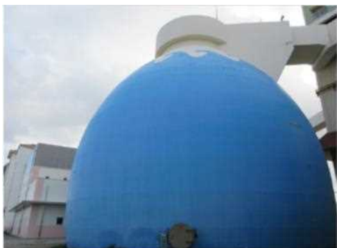
汚泥消化タンク
