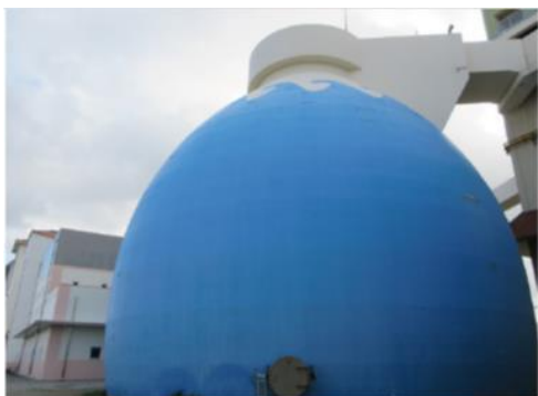
汚泥消化タンク
