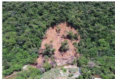
羽地大川 被災状況
