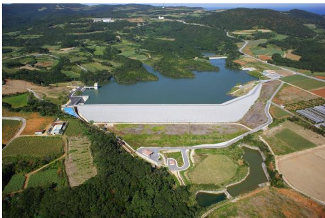
儀間ダム(平成 28 年 1 月撮影)
