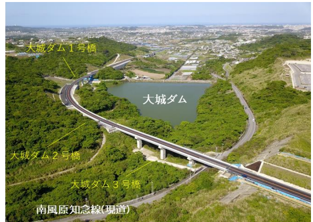
▲南風原知念線（南部東道路）区間③完成写真
