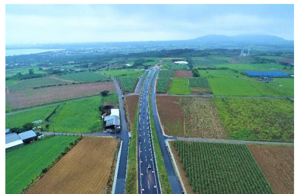
▲石垣空港線 令和5年度部分供用開始箇所
