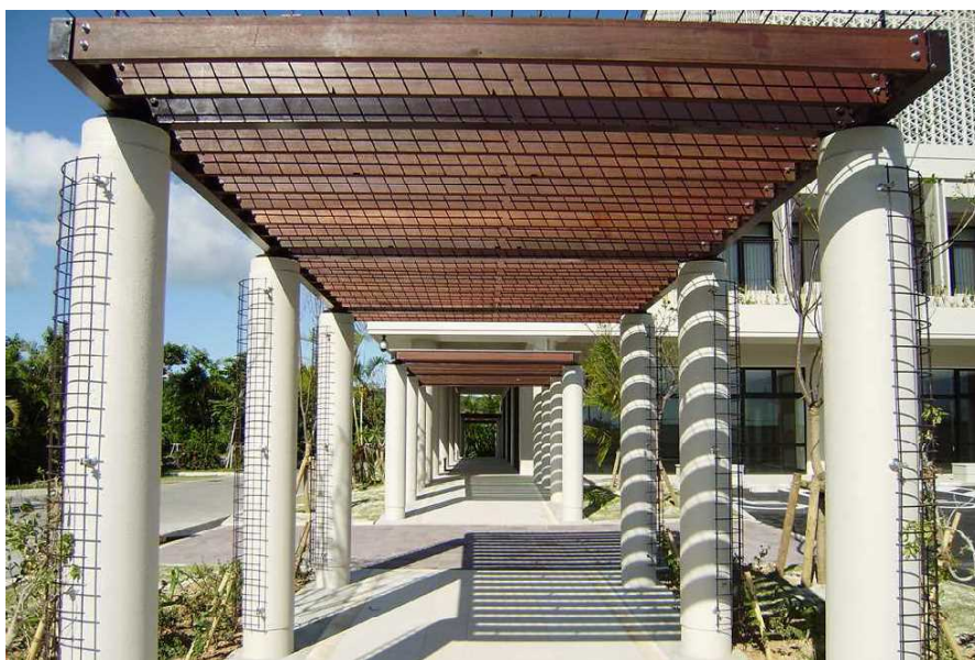
木質系材料を歩廊屋根にデザイン(中核機能支援施設)
