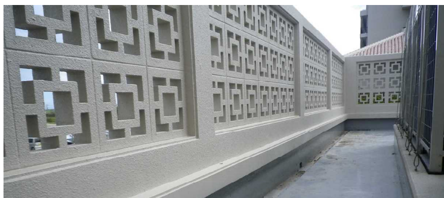
屋上設備機器の目隠しとしての有孔ブロック(中核機能支援施設)
