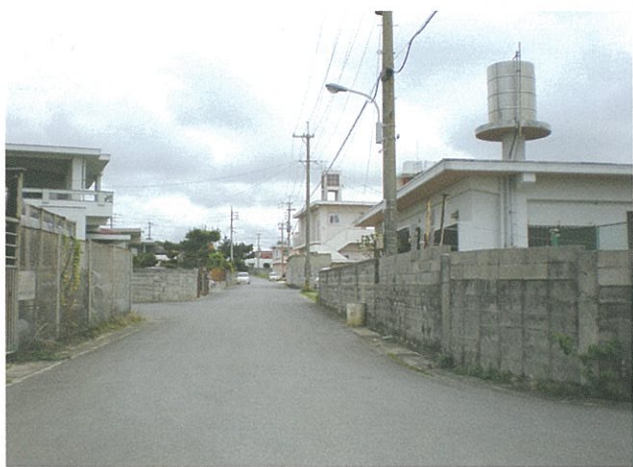
宇座復帰先地整備事業地区 平成21年3月
