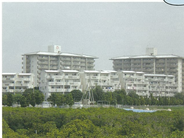
県営比屋根団地 平成21年3月
