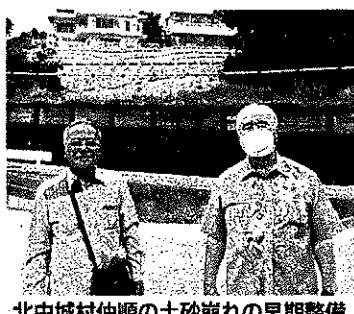
北中城村仲順の土砂崩れの早期整備要請(2020年9月) 令和3年に完成
