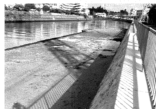
石川川護岸改修・浚渫工事完了 (台風等水害対策に期待)
