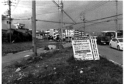
国道507号工事進捗 東風平交差点から中学校向け
