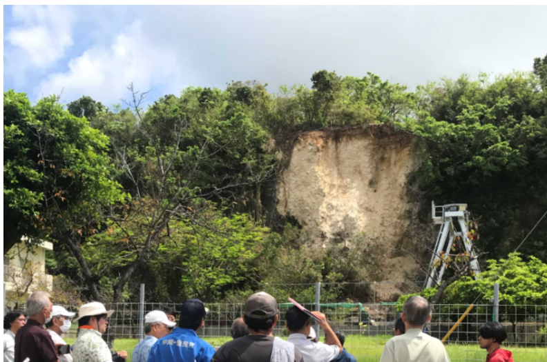
【崩落現場を視察】
