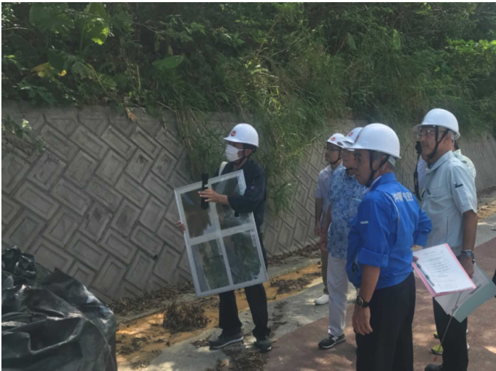
【被害状況の確認】
