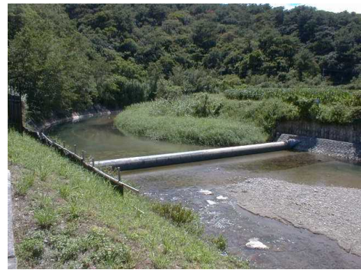
源河川取水施設
