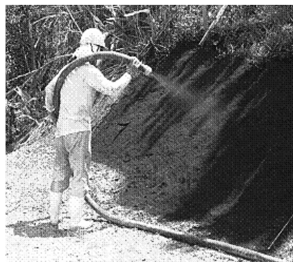
写真-1 吹付状況
